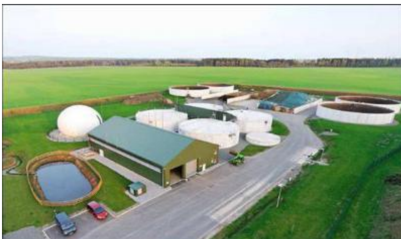
Rys. 6.31. Instalacja biogazowni w Marsberg w Niemczech
