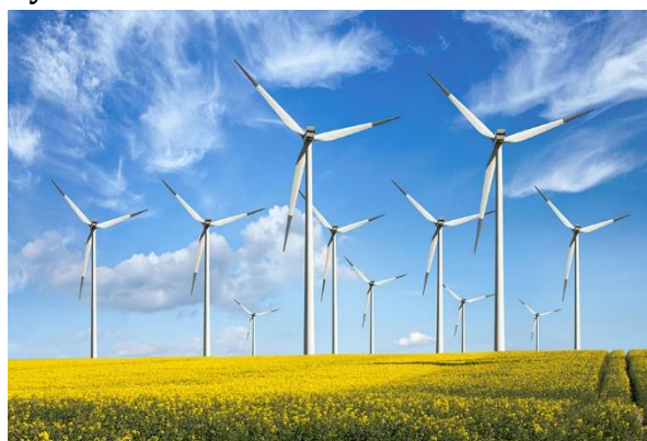
Rysunek 8.2. Elektrownia wiatrowa
